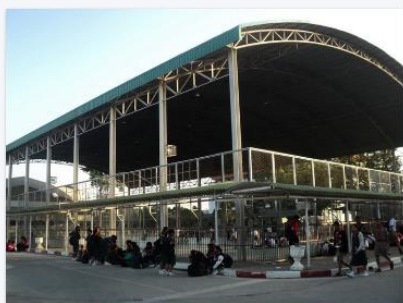
หลังคาคลุมลานอเนกประสงค์ขนาดใหญ่ (มีพื้น ค.ส.ล.)
