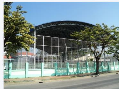
หลังคาคลุมลานอเนกประสงค์ขนาดใหญ่ (มีพื้น ค.ส.ล.)
