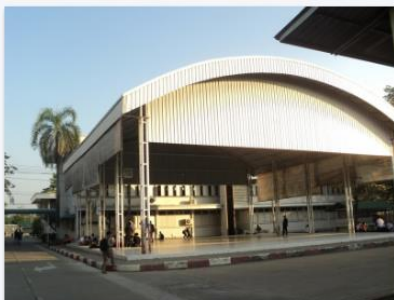
หลังคาคลุมลานอเนกประสงค์ขนาดเล็ก (มีพื้น ค.ส.ล.)
