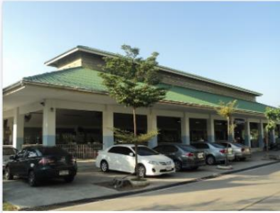
ร้านอาหาร (300 ที่นั่ง) ประเภทสิ่งก่อสร้าง ร้านอาหาร อายุการใช้งาน 13 ปี
