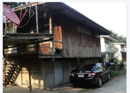
กรมสามัญ ประเภทสิ่งก่อสร้าง บ้านพักครู อายุการใช้งาน 52 ปี
