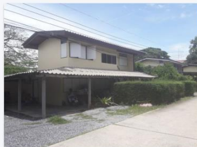
กรมสามัญ ประเภทสิ่งก่อสร้าง บ้านพักครู อายุการใช้งาน 41 ปี
