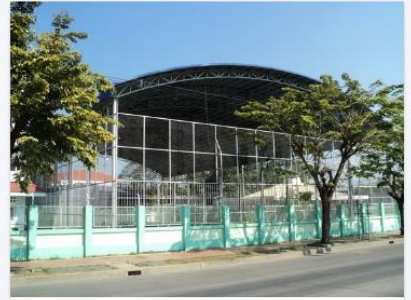
หลังคาคลุมลานอเนกประสงค์ขนาดใหญ่ (มี พื้น ค.ส.ล.) ประเภทสิ่งก่อสร้าง หลังคาคลุมลานอเนกประสงค์ อายุการใช้งาน 16 ปี
