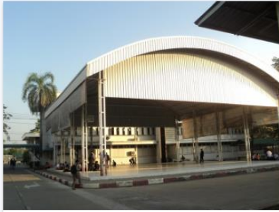
หลังคาคลุมลานอเนกประสงค์ขนาดเล็ก (มีพื้น ค.ส.ล.) ประเภทสิ่งก่อสร้าง หลังคาคลุมลานอเนกประสงค์ อายุการใช้งาน 19 ปี
