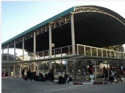
หลังคาคลุมลานอเนกประสงค์ขนาดใหญ่ (มี พื้น ค.ส.ล.) ประเภทสิ่งก่อสร้าง หลังคาคลุมลานอเนกประสงค์ อายุการใช้งาน 14 ปี
